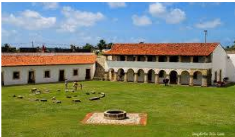
Fortaleza de Santa Catarina —pátio interno. Demonstrando a boa conservação do monumento sob a coordenação das ONGs Fundação Fortaleza de Santa Catarina – FFSC e AACC, apoiadas pelas demais ONGs ali sediadas. Atualmente a FFSC se mantém a partir
